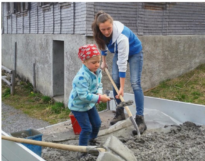
Betonieren einer neuen Garagenmauer auf dem Älpli.
